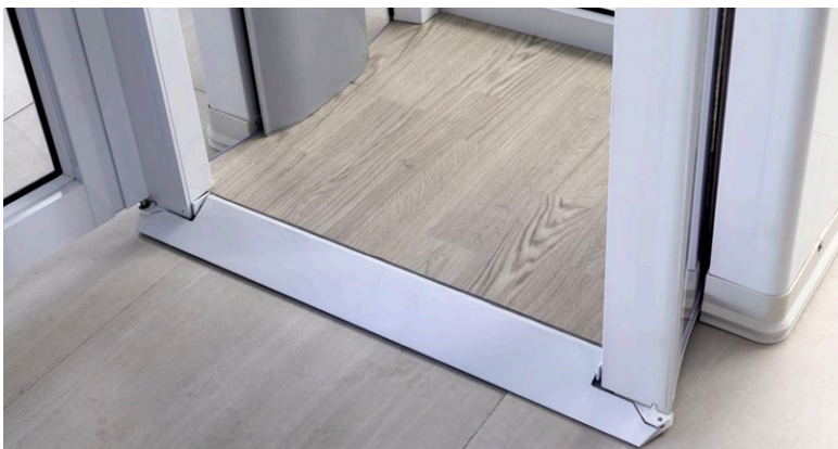
Abgeschrägte Schwelle und rutschfester Bodenbelag
