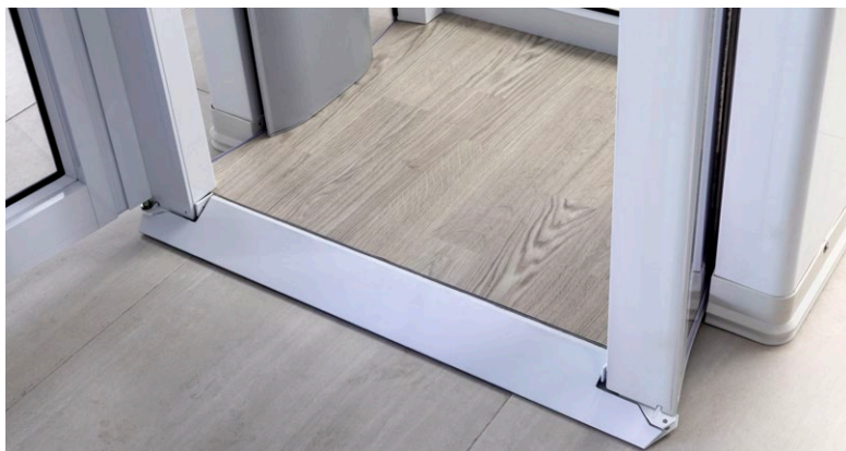
Seuil incliné et revêtement de sol antidérapant
