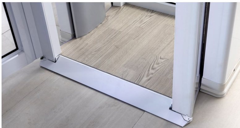
Seuil incliné et revêtement de sol antidérapant
